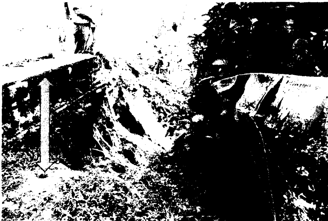
Foto No. 4. Diferencia de nivel entre lo construido y el terreno producto del mal manejo de aguas de escorrentía a través del tiempo
