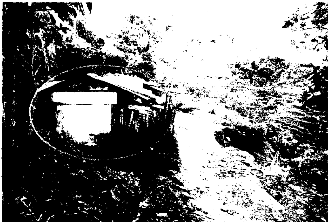
Foto No. 2 Casa que ha invadido la zona de la vía y que incrementa la problemática por el mal manejo de las aguas
