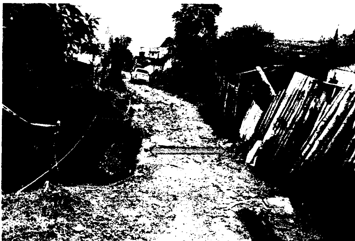
Foto No. 1 Ancho de la vía por donde transitan vehículos y porción de banca que se desplomo.
